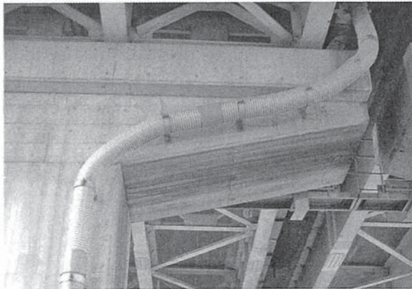
TNTフレキ管 施工例
